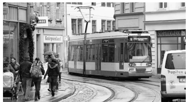
Die Große Ulrichstraße vor dem Umbau.
