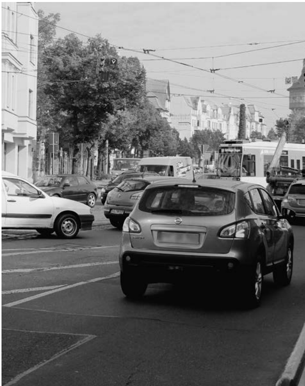
Alltäglich: unübersichtliche Verkehrsführung vor dem Umbau.
