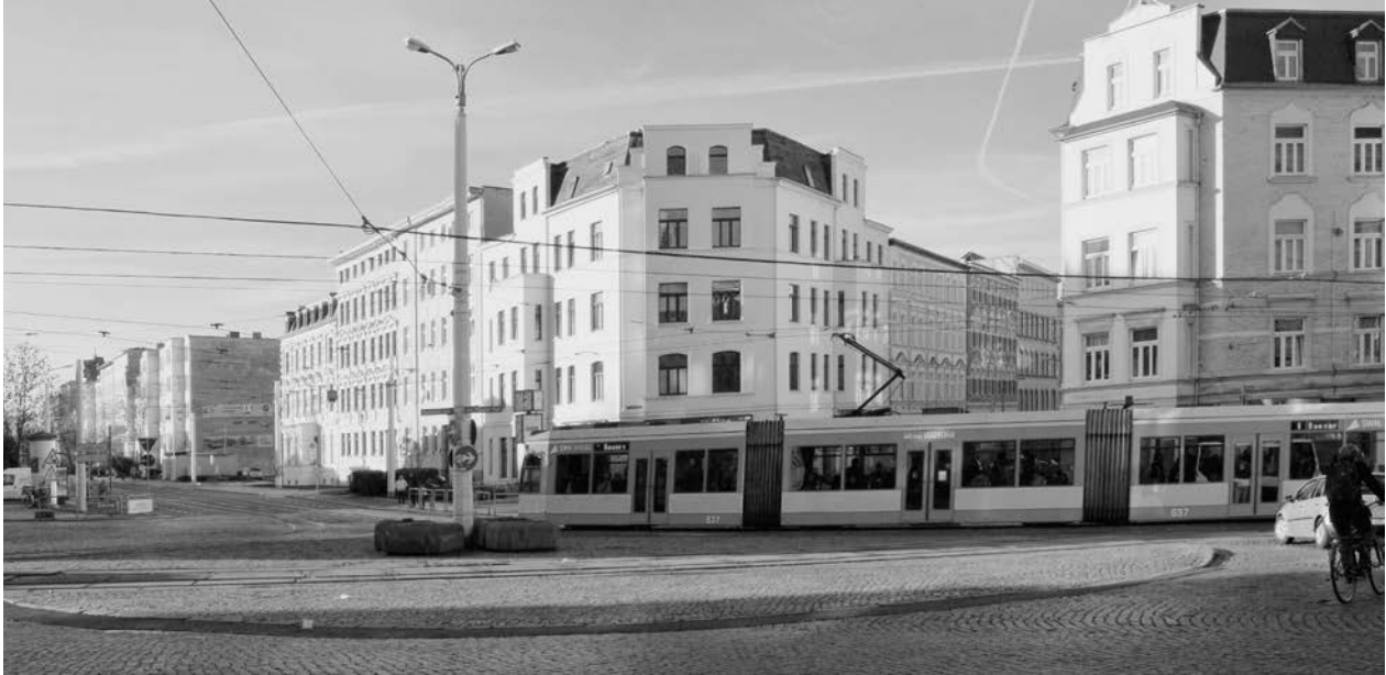
Der Rannische Platz vor der Modernisierung.
