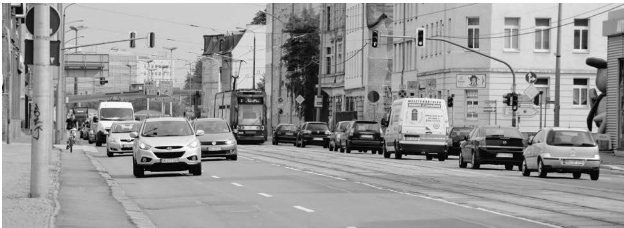
Die Merseburger Straße vor dem Umbau.
