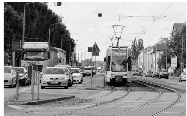
Die Dessauer Straße vor dem Umbau.
