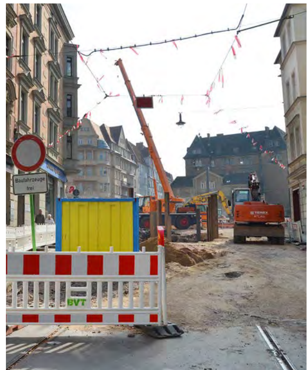
Auch die unterirdischen Versorgungsleitungen wurden erneuert.
