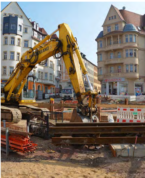
Der Rannische Platz während des Umbaus.
