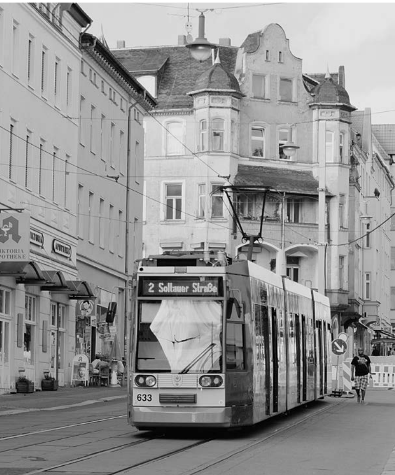
Die Große Steinstraße vor dem Umbau.
